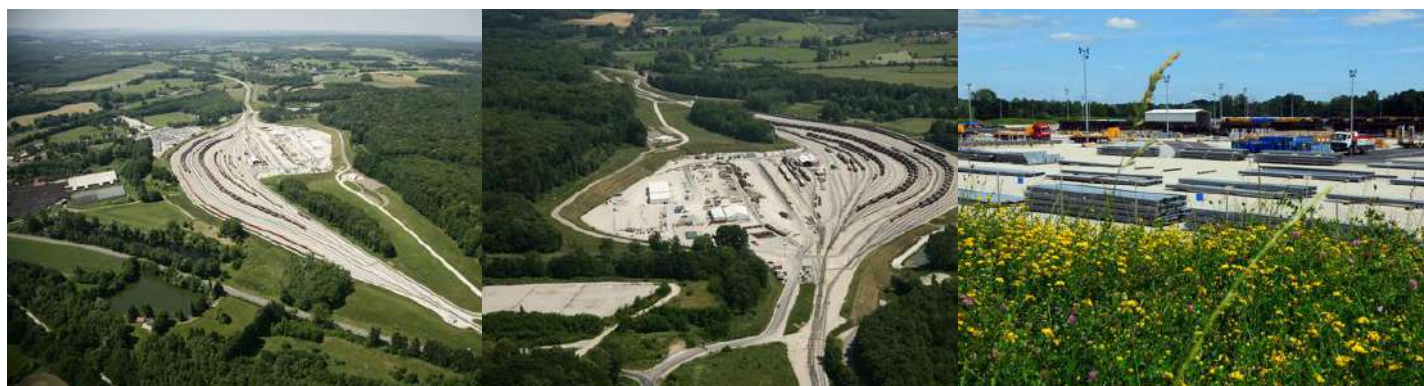
La base travaux à Villersexel 6
