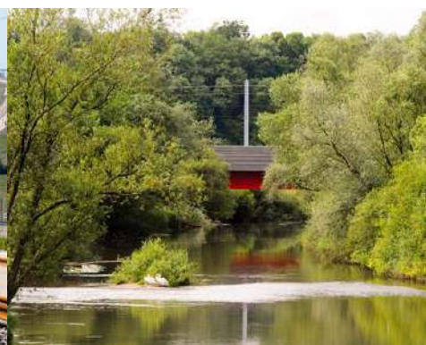
LGV-Le viaduc de l'Ognon à Tressandans 4
